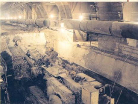
Основные достоинства обделок из АМБ - металлоемкость сниженная в 2-2,5 раза, надежная изоляция при повышенном гидростатическом давлении, возможность выполнения функции временной крепи до бетонирования АМБ.
