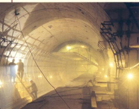
Особенность новой технологии сооружения одной из станций заключается в том, что ее проемные части сооружаются до проходки всех трех станционных тоннелей. Данная технология позволяет избежать монтажа и демонтажа дорогостоящих фасонных тюбингов и трудоемких работ по разработке проемов.
